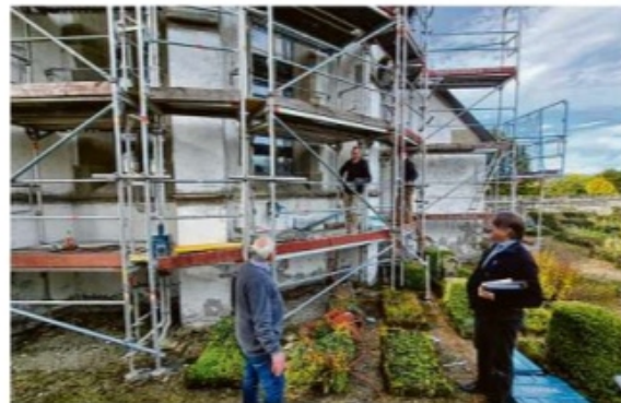
Im Außenbereich der Stephanuskirche in Gruorn laufen derzeit die Steinmetzarbeiten. Die Hoffnung auf einen milden Winter ist groß.
